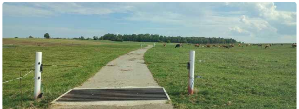
Weideroste können effektive Lösungen darstellen, jedoch nur unter Berücksichtigung der Gefahren für die Straßenteilnehmer © Rudlstorfer, LK OÖ
