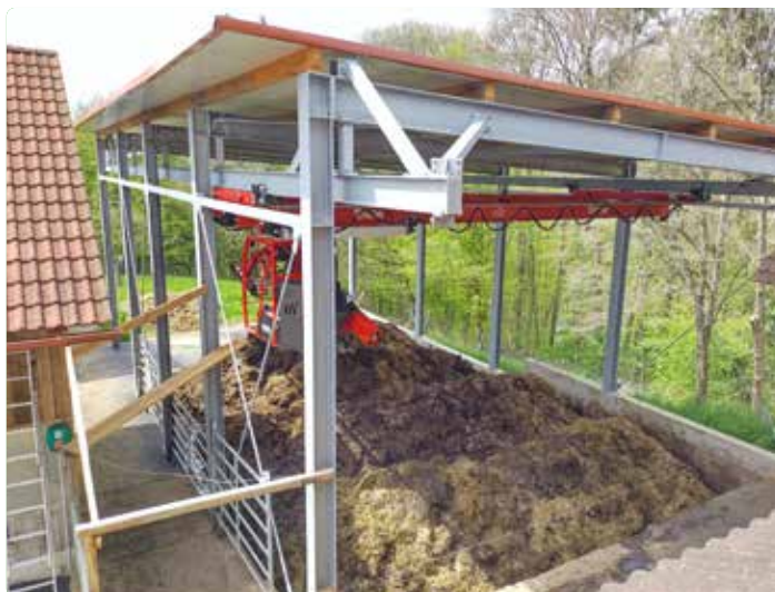
Befestigter Kompostplatz: Mit Überdachung und Kran ist eine optimale Steuerung von C/N-Verhältnis, Feuchtigkeit und Temperatur möglich.
