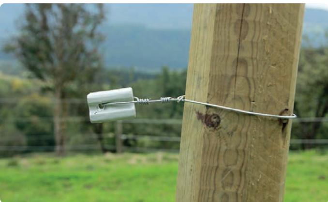
Spezielle Knoten zur Montage der Isolatoren und Federn.
